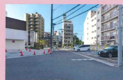
区画街路市道1-897号線
