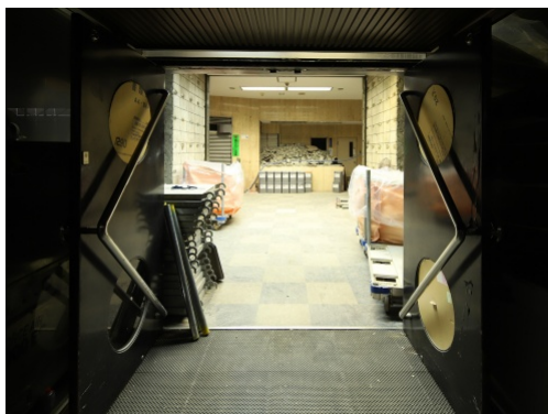
内装の解体が進む1階ホールの様子（写真：安川 千秋）
