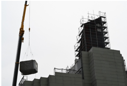
カプセルの取り外しはB棟から始めた（写真：日経クロステック） 【画像のクリックで拡大表示】
