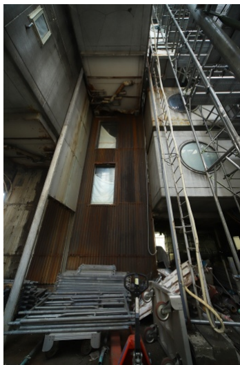
上階から解体作業を進めるためにカプセルの周囲に足場を組んでいる (写真: 安川 千秋) [画像のクリックで拡大表示]
