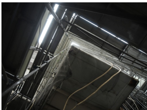
カプセルによって建物の外周部が独特な形状となるため、足場の組み方が複雑になる (写真：安川 千秋)
