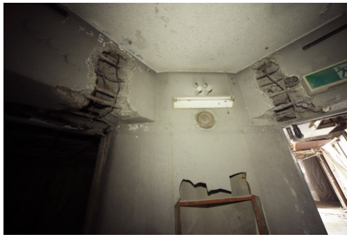
建物は鉄骨鉄筋コンクリート造で頑丈だ。解体作業を進めるために、柱と梁の接合部周辺のコンクリートの一部を事前に除去している (写真：安川 千秋) [画像のクリックで拡大表示]
