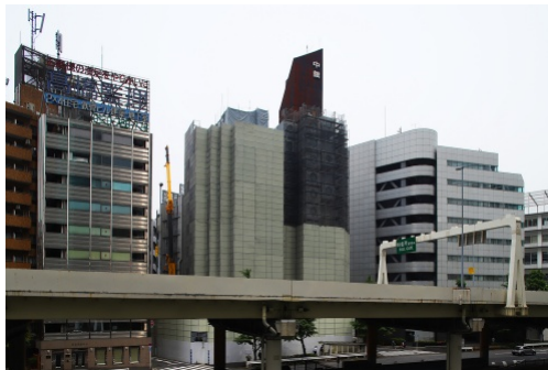
建物正面を走る東京高速道路の高架越しに中銀カプセルタワービルを見る。右が13階建てのA棟で、左が11階建てのB棟。B棟は塔屋が撤去済みだ（写真：安川 千秋） 【画像のクリックで拡大表示】
